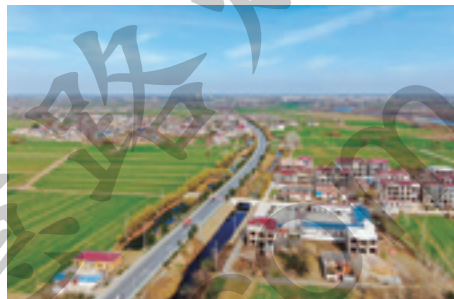
修建安徽省利辛县刘圩村道路
