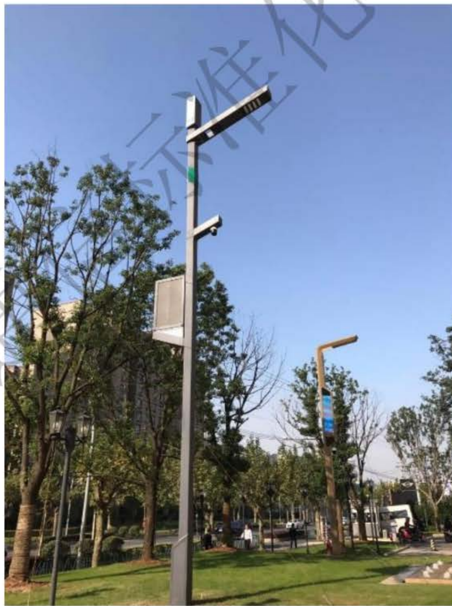
图 3-1 搭载 5G 微基站的智慧杆
