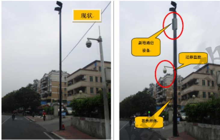
通信设备+路灯杆+监控杆改造示意图
