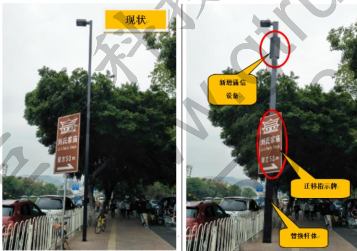
通信设备+路灯+指示牌改造示意图
